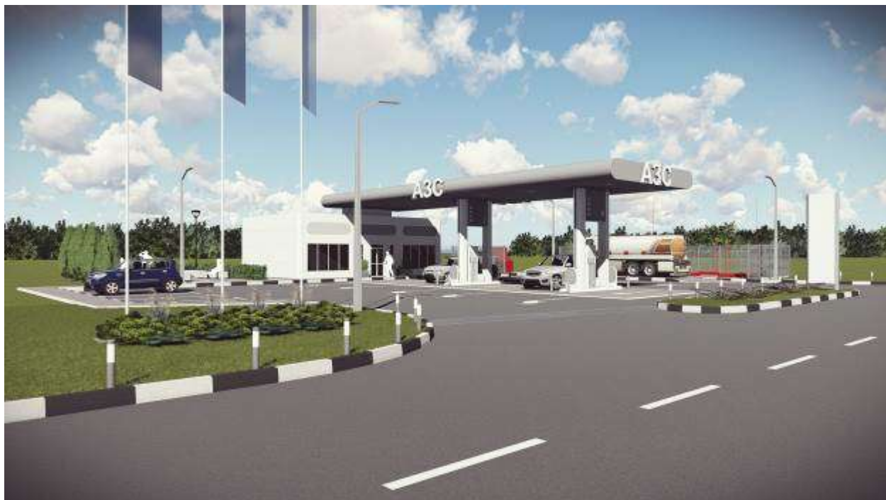
Подсветка островка и зоны въезда\выезда на АЗС
